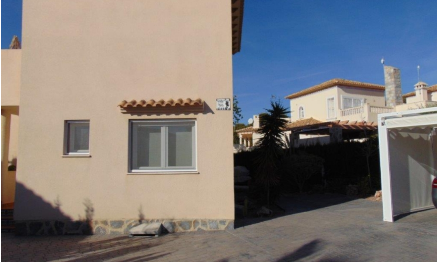
Grosse Garage, Las Ramblas Golf Resort, Alicante-La Blanca. Spanien
